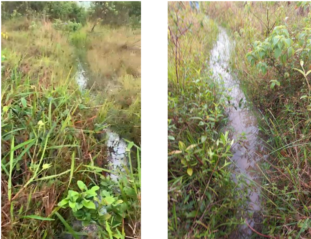
Figure 23 : Photographies de la tranchée de canalisation des eaux sur le site
